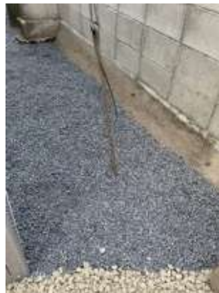
※6号碎石（砂利の一種）の仕上がり。踏むと音がすることから防犯砂利とも呼ばれる
