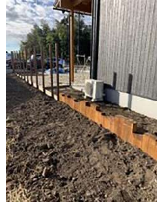
※このように枕木(30年経過しても腐らない防腐処理済のもの)を使うこともある
